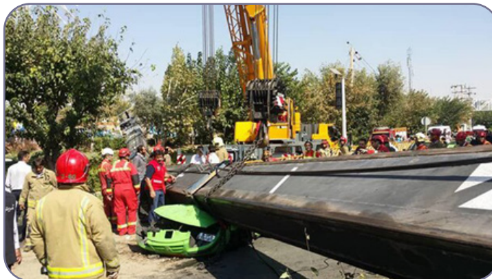
شکل ۷-۲-۲. صحنه‌هایی از حادثه سقوط جرثقیل متحرک در پارک بسیج تهران
