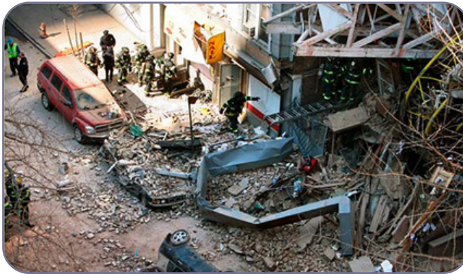
شکل ۷-۵. ساختمان تخریب شده در اثر سقوط جرتقیل برجی بوم زاویه‌گیر در نیویورک
