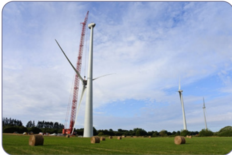
شکل ۲-۷. نصب پره توربین بادی به کمک جرثقیل متحرک
