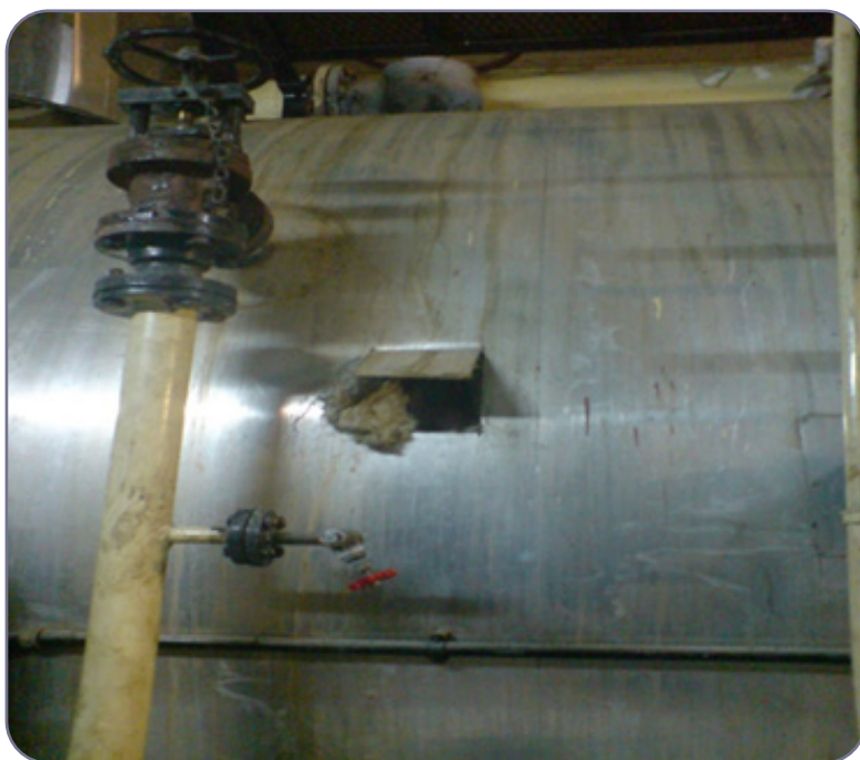
شکل ۱-۴ برش کاور بدنه دیگ برای انجام تست ضخامت سنجی
