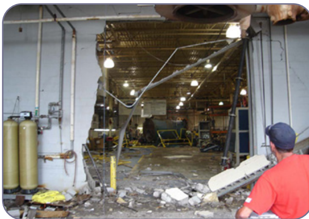
شکل ۲-۶ انفجار دیگ در شرکت DANA و تخریب قسمتی از دیگ خانه
