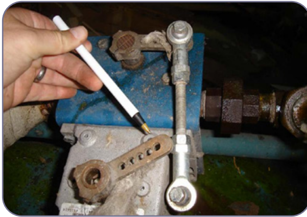
شکل ۳-۶ شناور آب تغذیه
