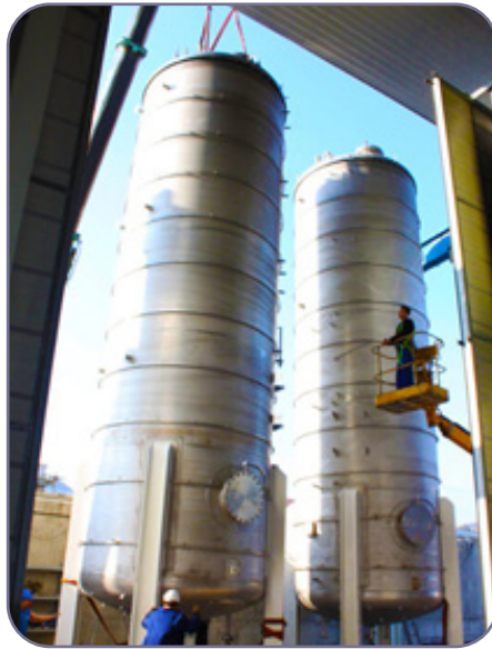
شکل ۳-۲ مخزن تحت فشار استوانه‌ای عمودی
